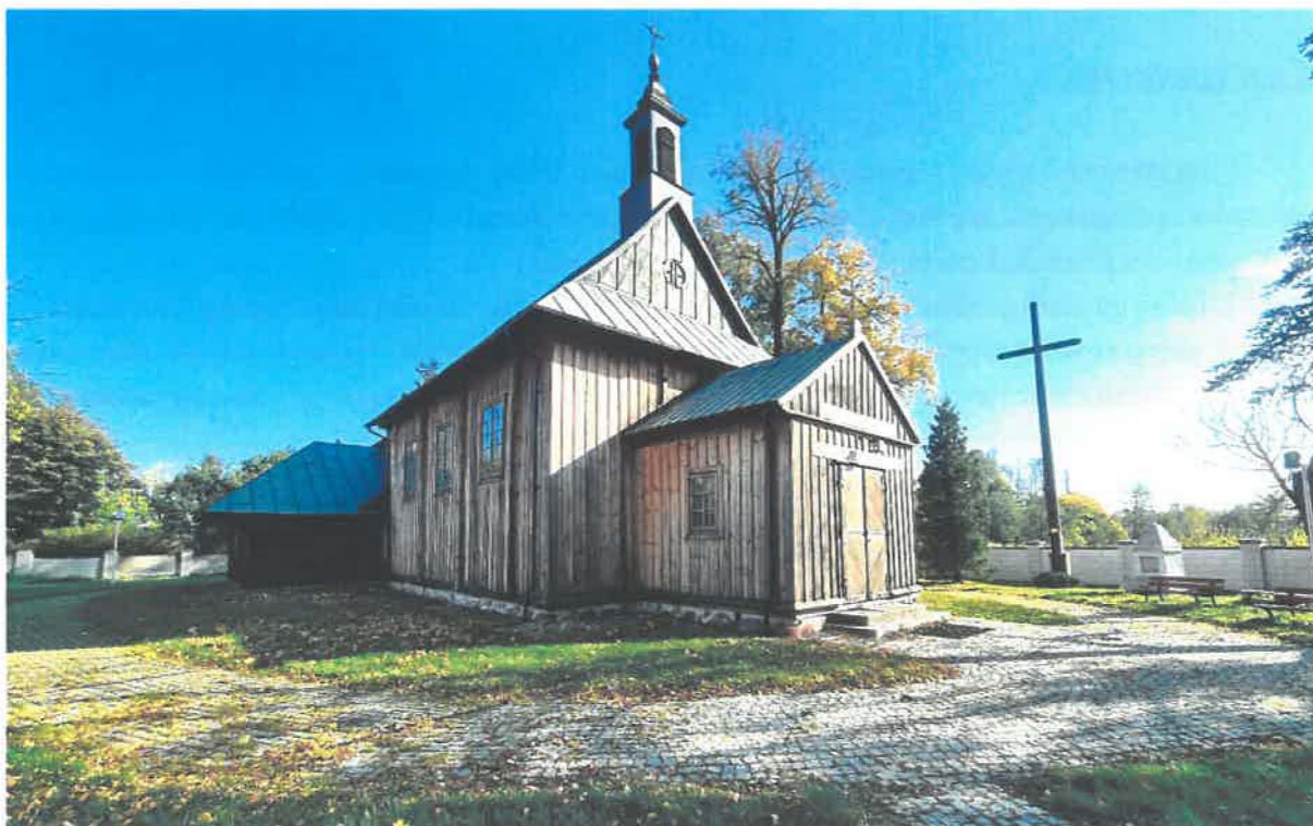
Kościół p.w. Przemienienia Pańskiego w Żukowie
