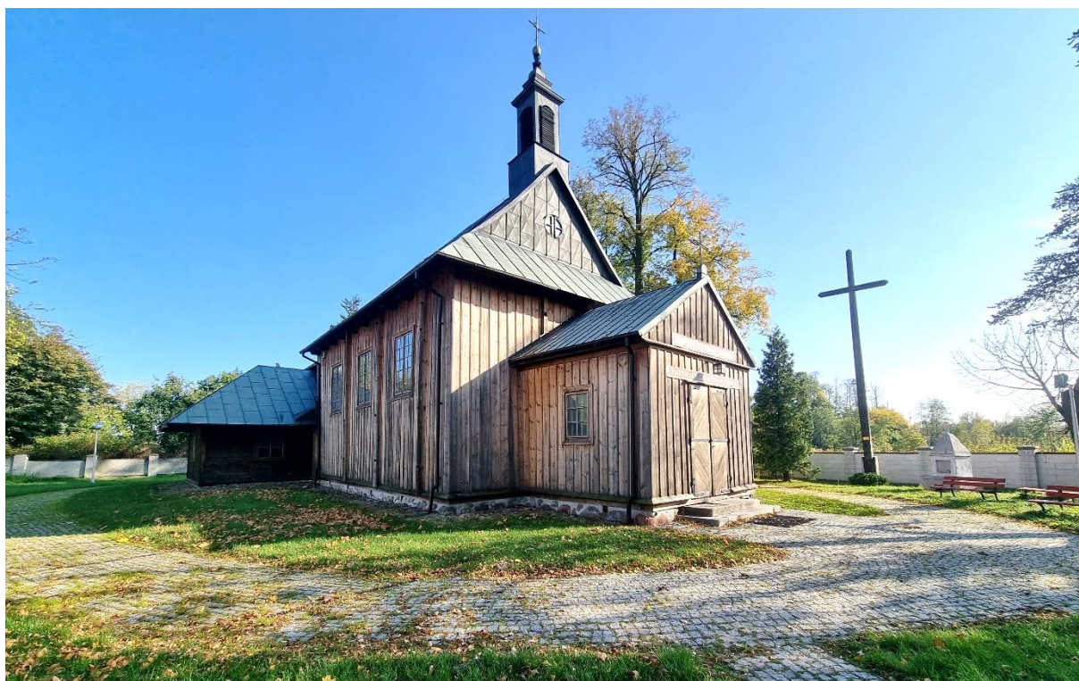
Kościół p.w. Przemienienia Pańskiego w Żukowie
