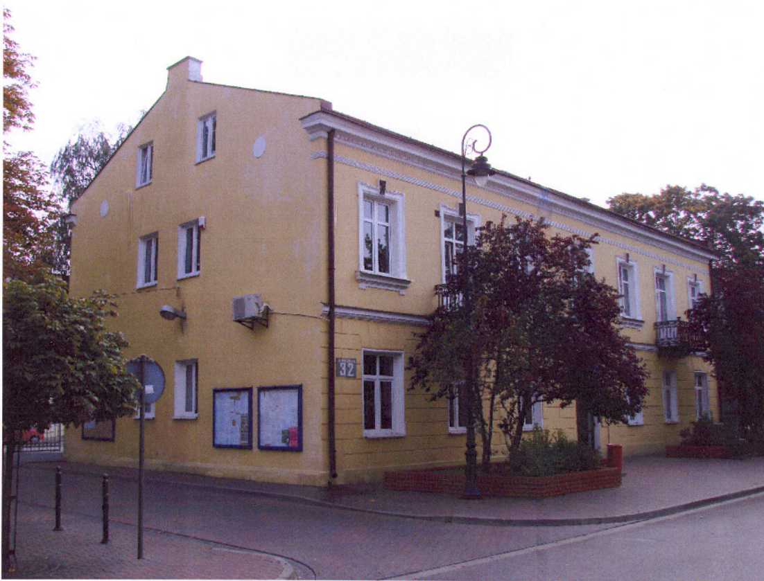
Fot. 1. Elewacja południowo-zachodnia i elewacja północno-zachodnia.
