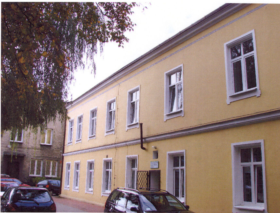
Fot. 2. Elewacja północno-wschodnia.
