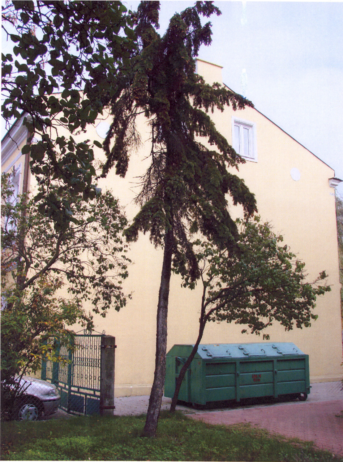
Fot. 3. Elewacja południowo-wschodnia.
