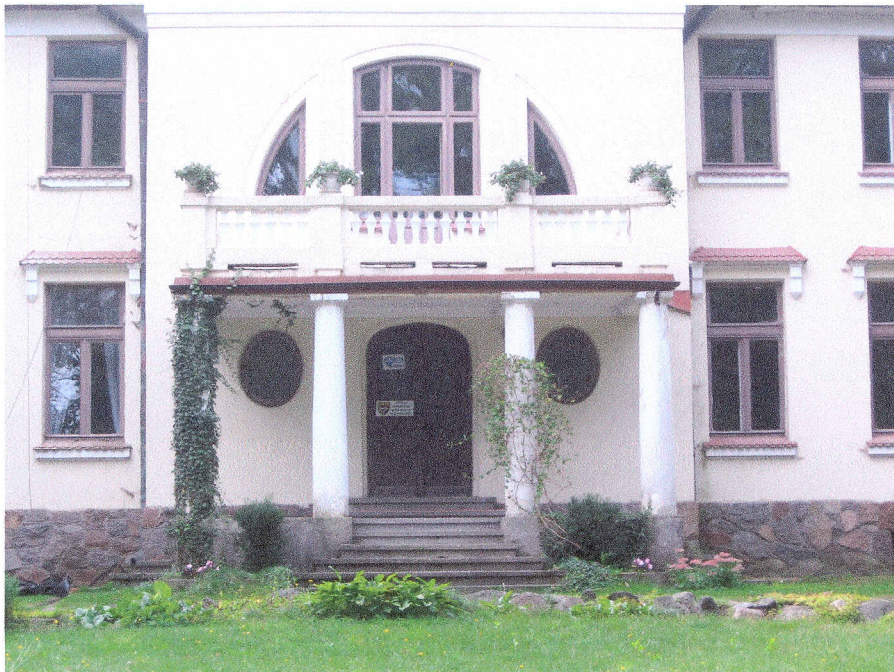
4.1.1. widok portyku zwieńczonego tarasem od strony płn. – wsch
