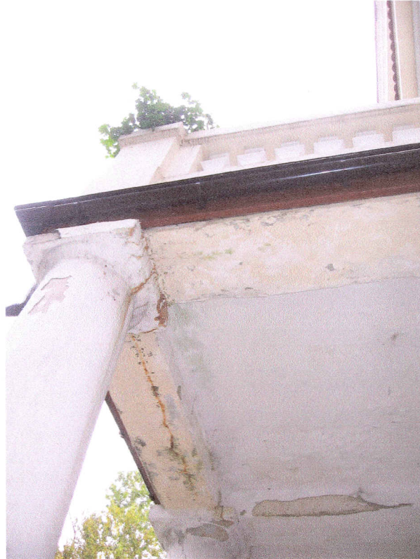
4.1.6. widok spodu płyty tarasu, przeszło płn. - zach.
