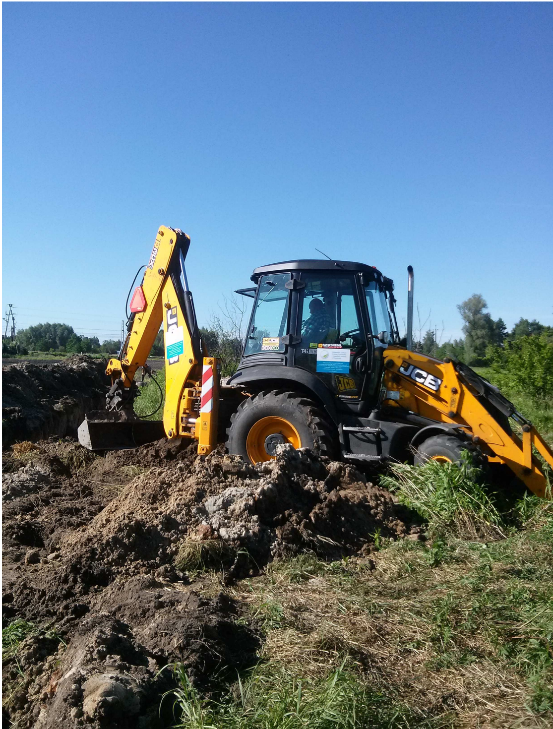
Fot. 10. Koparko ładowarka zakupiona z dotacji WFOŚ w Warszawie
