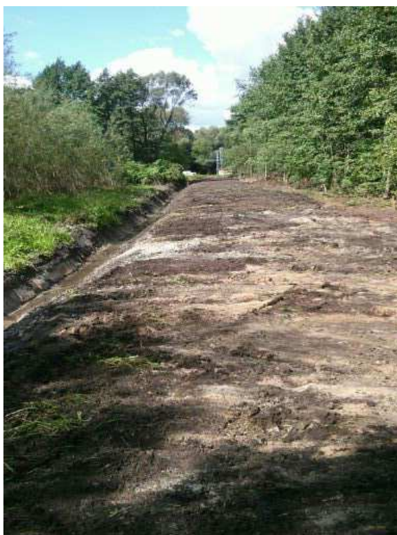
Fot. 6 Etap końcowy modernizacji rowu melioracyjnego przy ul. Malinowej
