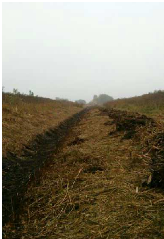
Fot. 8 Konserwacja rowu melioracyjnego w Chlebni - po
