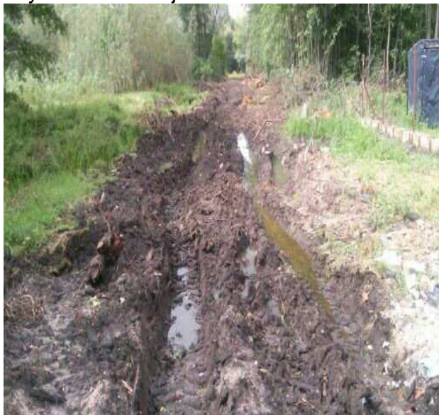
Fot. 5. Etap konserwacji rowu melioracyjnego przy ul. Malinowej
