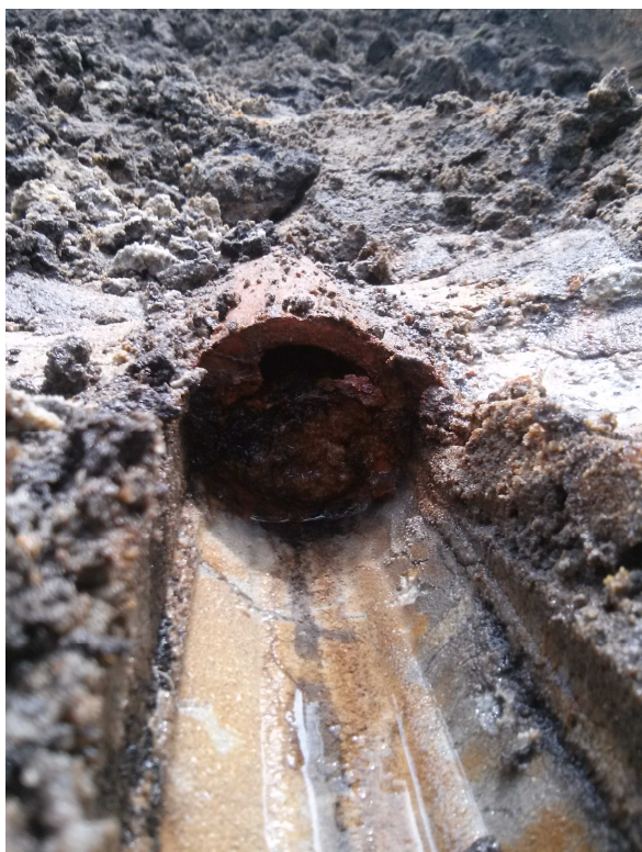
Fot. 9 Usuwanie awarii drenu
